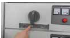
将移动钮左拨，闭锁解锁钮和摇杆孔
